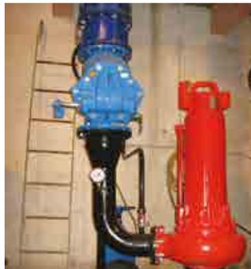
RÜCKSCHLAGKLAPPE MIT HEBEL UND GEWICHT
